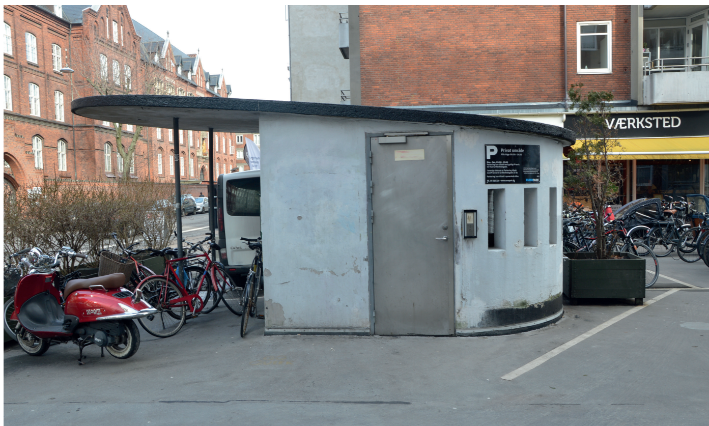
Kiosken indeholder i dag en trappenedgang til parkeringskælderen og bliver ofte benyttet som pissoir.
